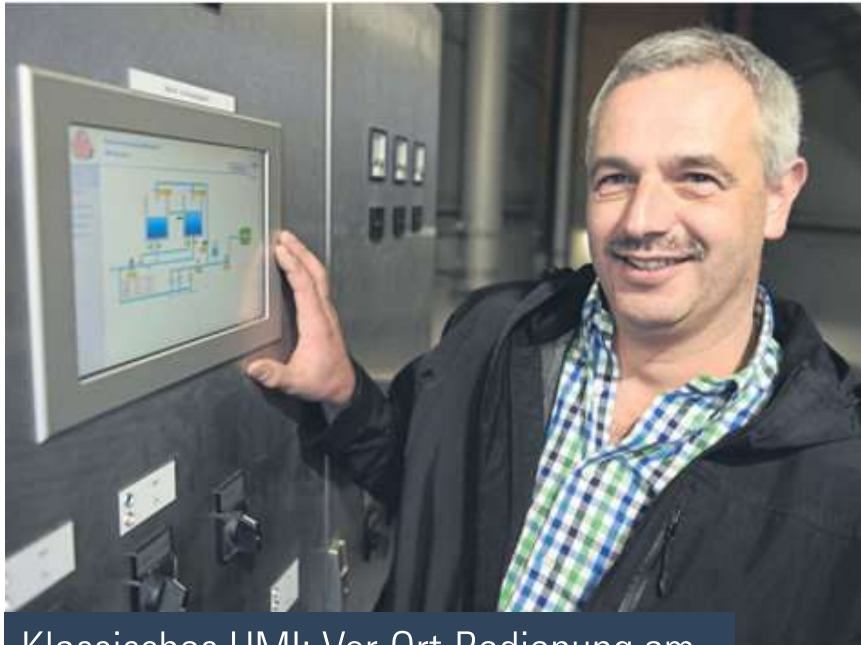
Klassisches HMI: Vor-Ort-Bedienung am Touchpanel im Schaltschrank [WV Miesbach]
