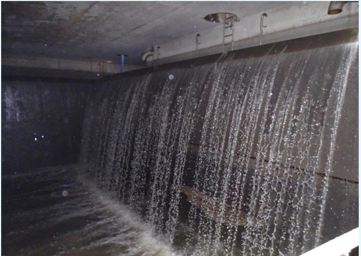
Bild 1 Überlaufkante eines Stauraumbeckens in Nürnberg
