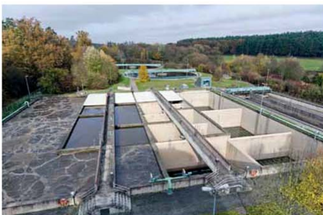
Die Schwabacher Kläranlage
