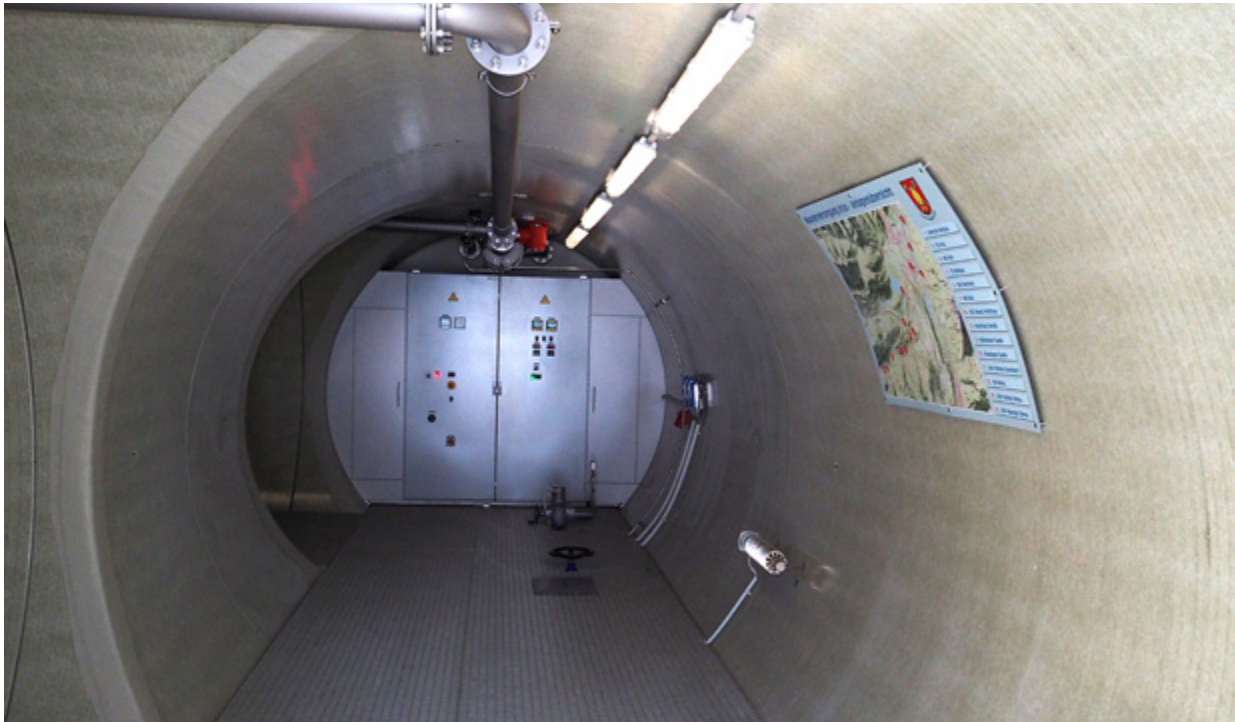
Bild 1: Der neu gebaute Hochbehälter Elmau — eine Glasfasersonderkonstruktion
